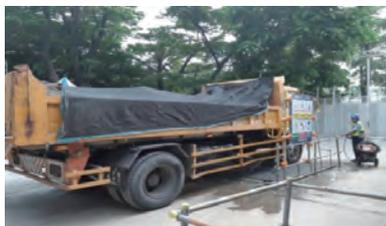
車輛離開工地前派員以加壓沖洗設備加強輪胎之清洗
