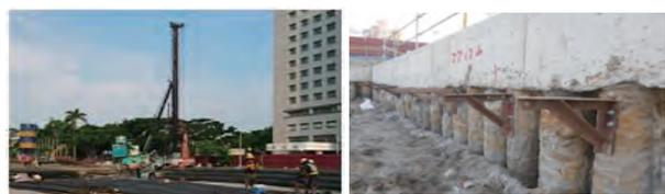
選用低污染施工工法以降低噪音對環境之衝擊-預疊樁工法(擋土排樁)
