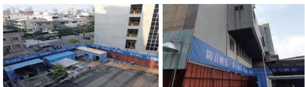
甲種鋼板圍籬加高防音並加設防音帆布補強降低噪音
