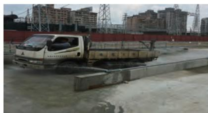
車輛出工區前輪胎沖洗防止泥濘污染工區外道路
