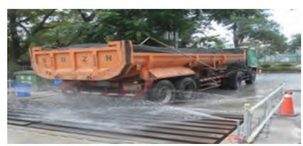
車輛離開工地前經過洗車臺設備加強輪胎之清洗
