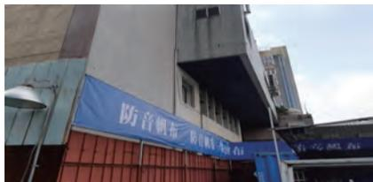
甲種鋼板圍籬加高防音並加設防音帆布補強降低噪音
