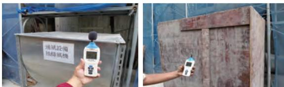
抽排氣通風設備設置吸音棉護圍、隔音圍籬防制噪音
