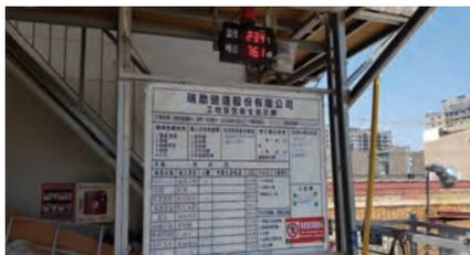
施工中噪音檢測-工區內設制噪音監測
