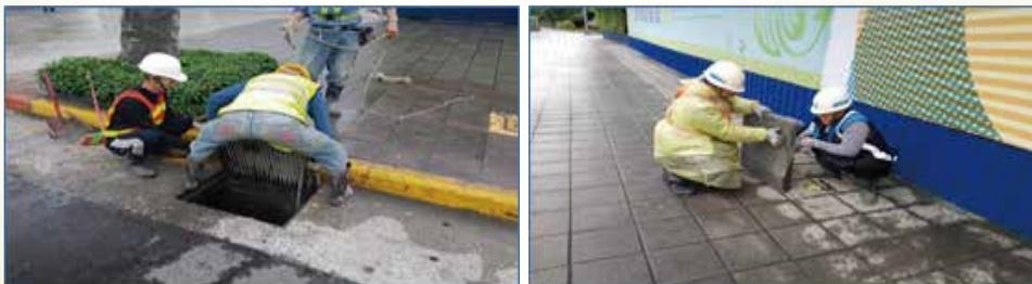
工地周邊排水系統清理及水溝蓋鋪設防砂網
