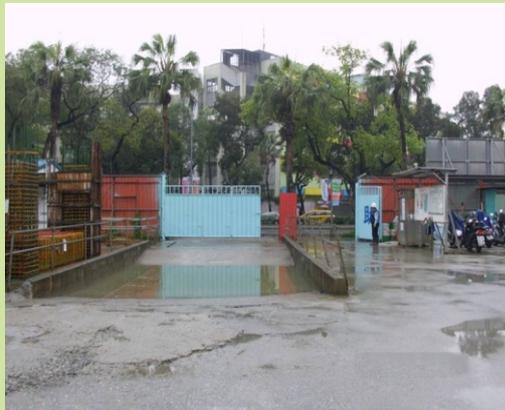
各工地出入口處皆設置洗車台及沉澱池
