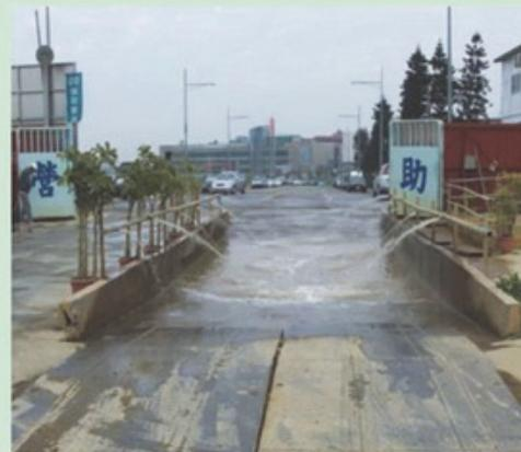
工地進出口設置洗車台及鋪設鋼板防止施工車輛污染道路
