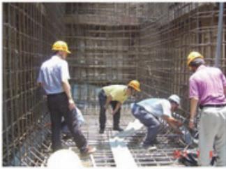
投中D/S涵洞鋼筋綁紮查驗
