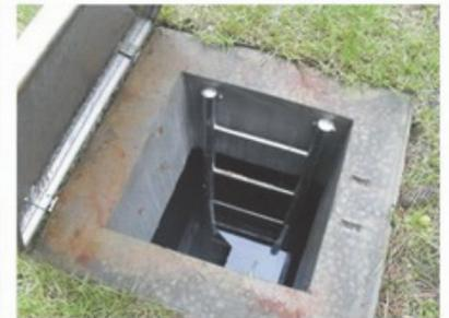
↑ 地下雨水回收槽：露台及屋頂裝設雨水落水頭，排入雨水回收池水供室內衛生器具、沖廁及景觀澆灌使用，達到節能減碳目的。
