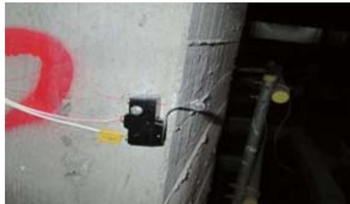
電梯口護欄處裝置簡易型微動開關
