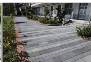
透水鋪面(高壓磚)示意圖
