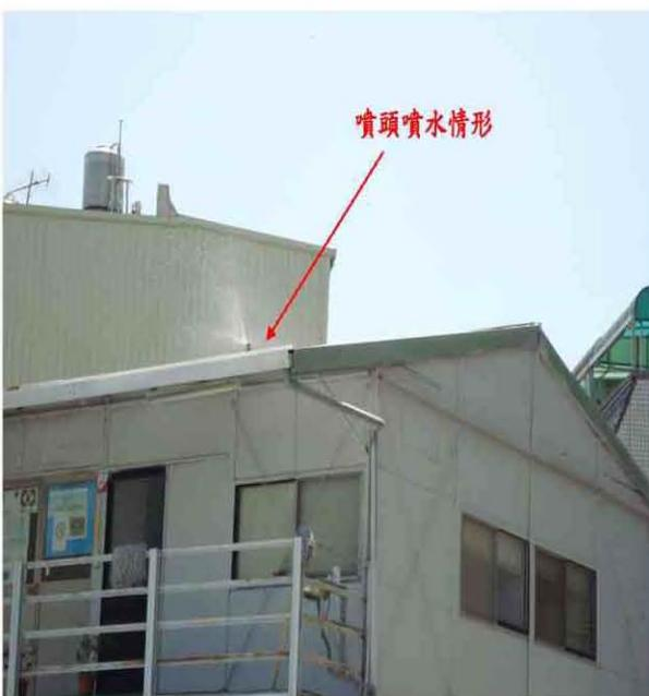
圖5.3.2-4 工務所噴水循環節能省電-降低工務系統溫度，減少冷氣使用
