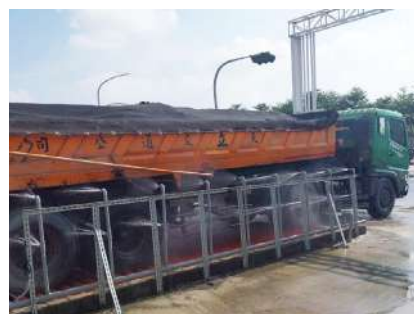
土方運輸車輛離場確實以防塵網緊密覆蓋車斗
