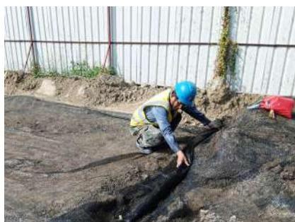
裸露地表覆蓋防塵網抑制揚塵
