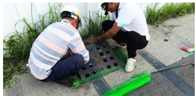
週邊水溝定時清理並加裝紗網，防止污染下水道及防治蚊蟲
