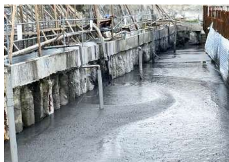
以劣質混凝土(CLSM)回填增進廢棄物再利用途徑
