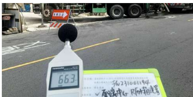
施工作業中監測大型機具音量分貝
