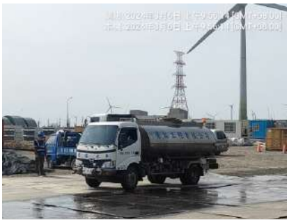
工區施工便道鋪設鐵板及定時灑水
