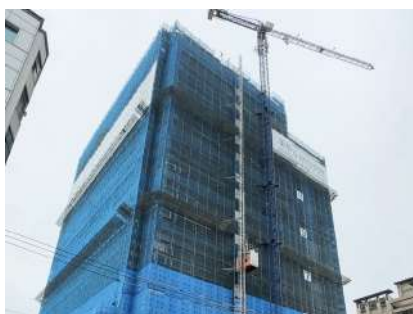
外牆施工架設置防塵網
