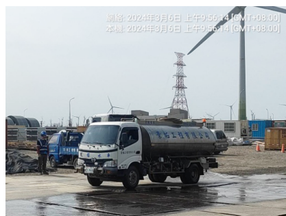
工區施工便道鋪設鐵板及定時灑水
