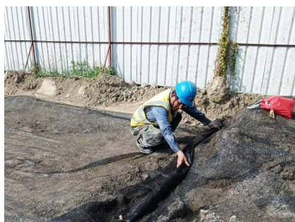
裸露地表覆蓋防塵網抑制揚塵
