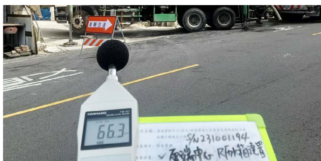
施工作業中監測大型機具音量分貝
