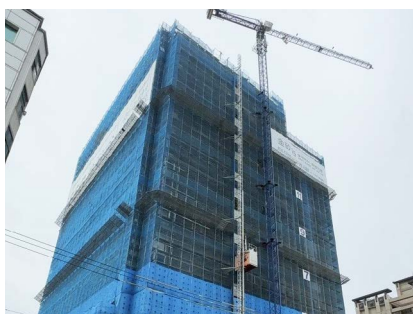
外牆施工架設置防塵網
