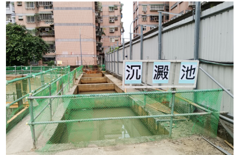
工地設置沉砂池
