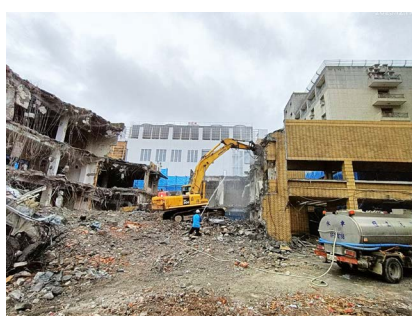
拆除作業期間持續灑水
