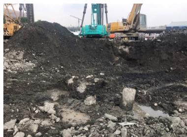
左圖：前鎮工址內發現大量混凝土塊及未拆除地下室
